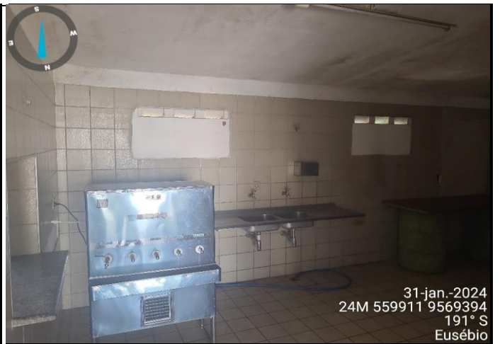
Benfeitorias - "Restaurante/Cozinha" (Interno)
