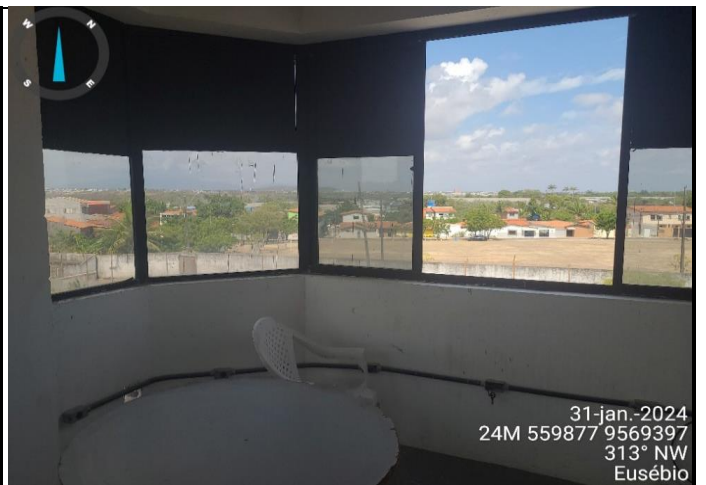
Benfeitorias - "Torre de Cronometragem" - Interno Pavimento 02
