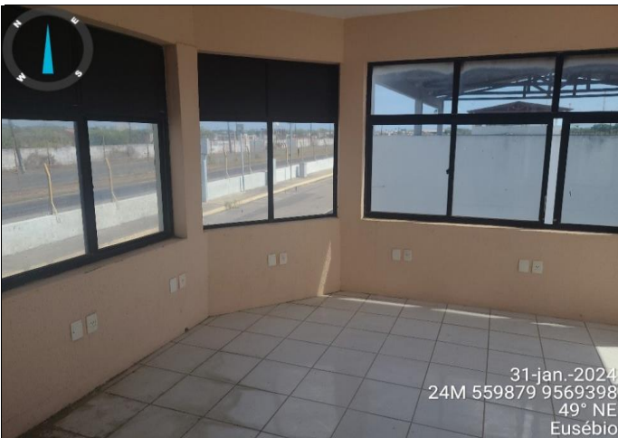
Benfeitorias - "Torre de Cronometragem" - Interno Pavimento 01
