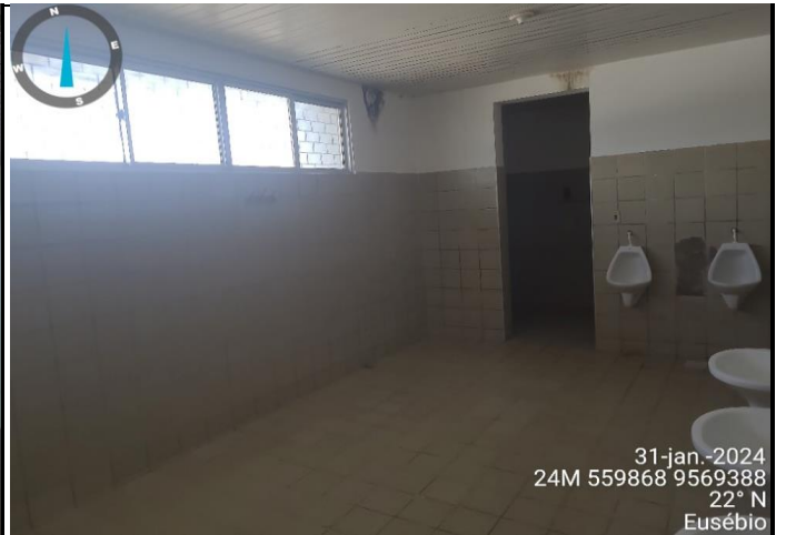
Benfeitorias - "Torre de Cronometragem" - Interno Térreo
