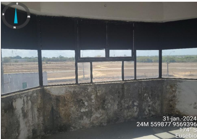
Benfeitorias - "Torre de Cronometragem" - Interno Pavimento 02
