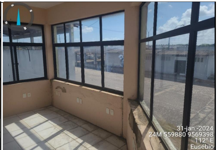
Benfeitorias - "Torre de Cronometragem" - Interno Pavimento 01
