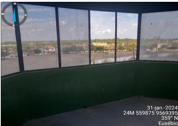
Benfeitorias - "Torre de Cronometragem" - Interno Pavimento 03
