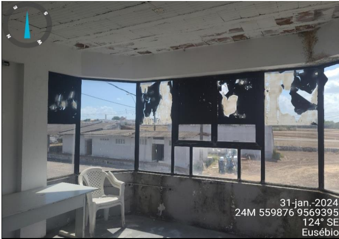
Benfeitorias - "Torre de Cronometragem" - Interno Pavimento 01.1
